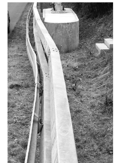
Bild 4: Unfallstelle im Bereich einer SR VZB
