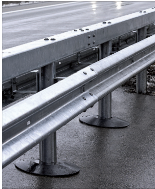
Bild 7: Dichtungskragen für Pfosten C 125 auf Mittelstreifenüberfahrten
