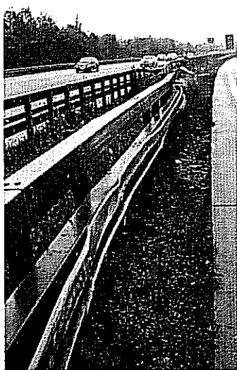
Fahrzeug-Rückhaltesystem Super-Rail nach extremem Anprall
