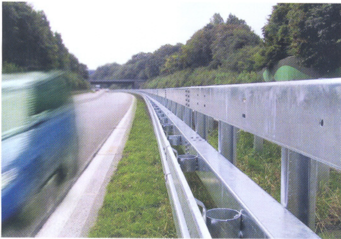
Beim System SUPER-RAIL, das verstärkt auch insbesondere in Nordrhein-Westfalen eingesetzt wird, ist bisher noch kein Durchbruch zu verzeichnen gewesen
