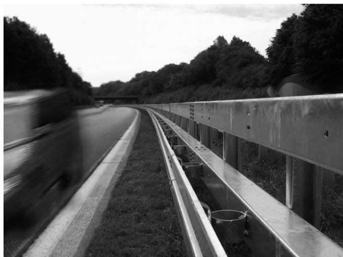
**Abb. 1:** Leistungsfähiges System *Superrail*: erfüllt Klasse H2 und H4b mit Restsicherheit Foto: Gütegemeinschaft Stahlschutzplanken e.V.
