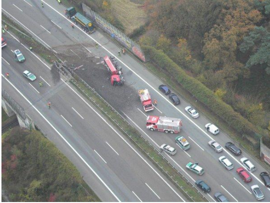
Mittelsteifendurchbruch einer EDSP-zweifach
